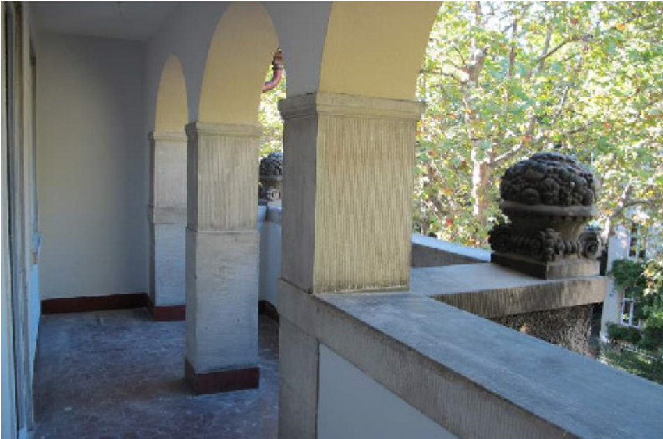
Balkonerker. Arnold Böcklin-Str. o.N., 4051 Basel
